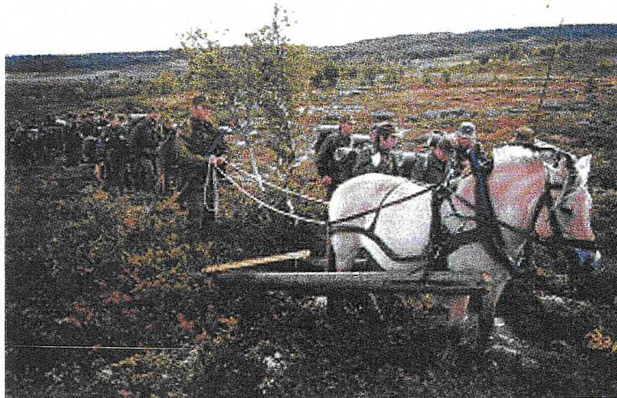
Biletet syner korleis karane ved hjelp av ein hest og ei litt serskilt oppspenning fekk frakta dei impregnerte stolpane frå Strypen og opp til Saurstjerna.
