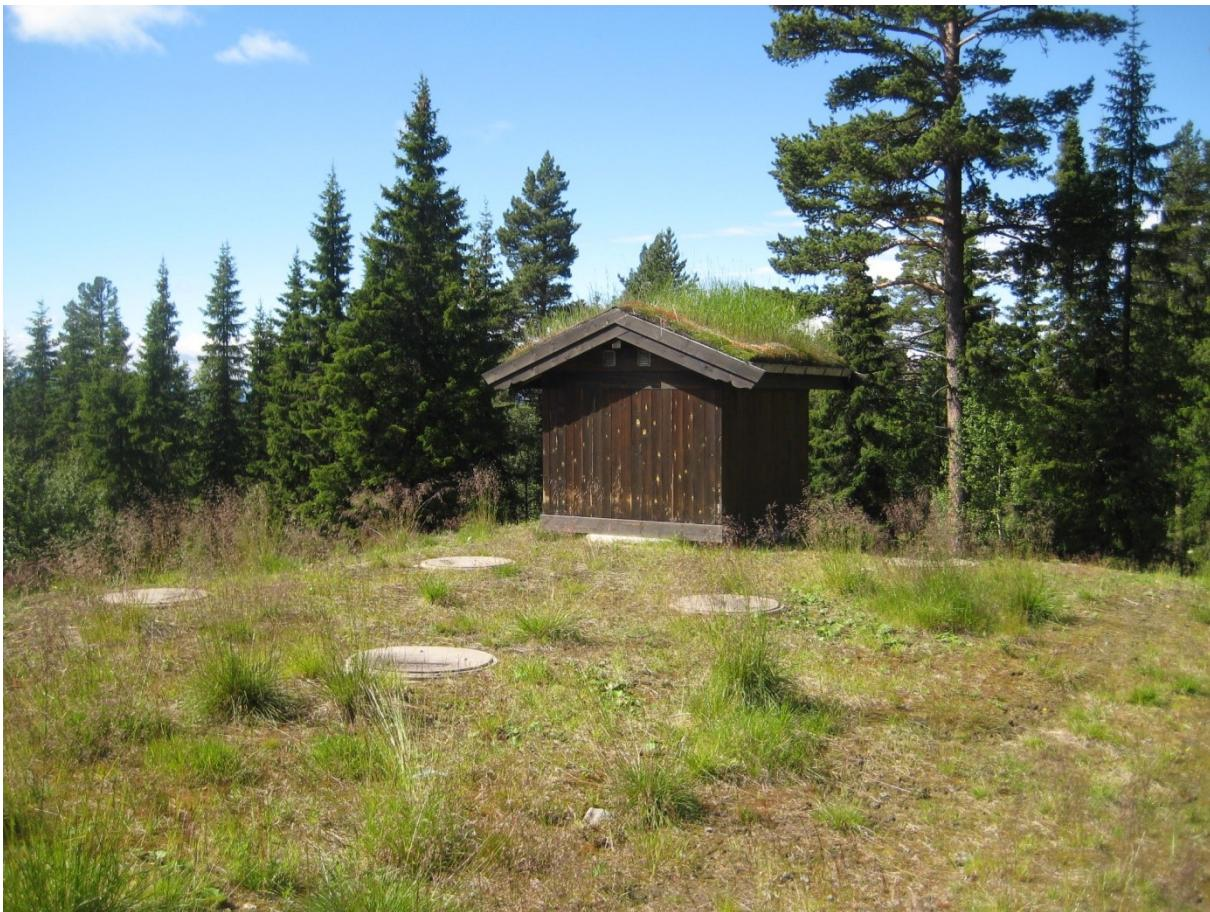
**Figur 21. Fullreinseanlegg (biologisk - kjemisk) med etterreinsing/etterpolering i stadeigne lausmasser ved Bjødnahølet hyttefelt. Denne type anlegg er vurdert som aktuell for lokale fellesløysingar med kapasitet inntil 1000 PE. Foto: Ø. Slidre kommune.**
