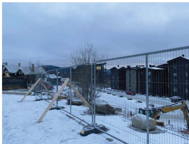
Dagens situasjon er preget av mye byggearbeider
