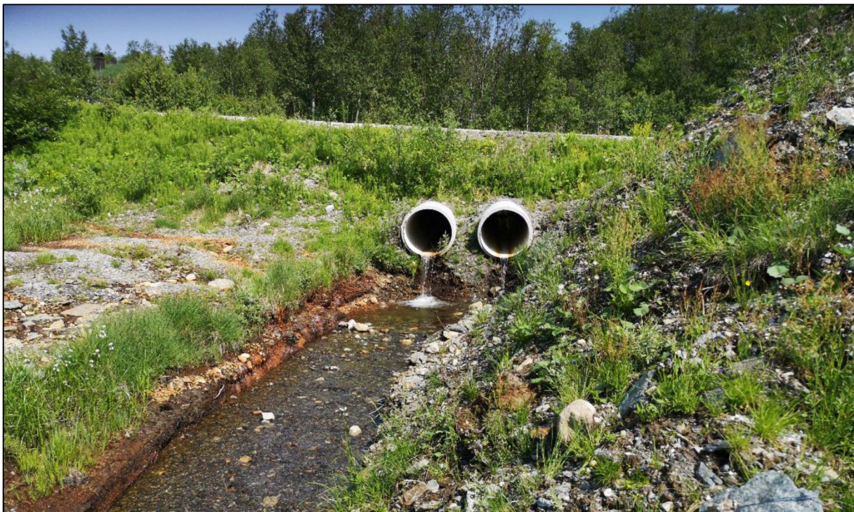
Figur 5: Utløp til stikkrenne 1 rett oppstrøms planområdet (2*800mm).
