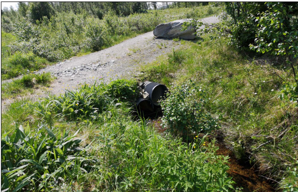
Figur 6: Stikkrenne nedstrøms planområdet som vil få økt flomvannføring (2*400mm).
