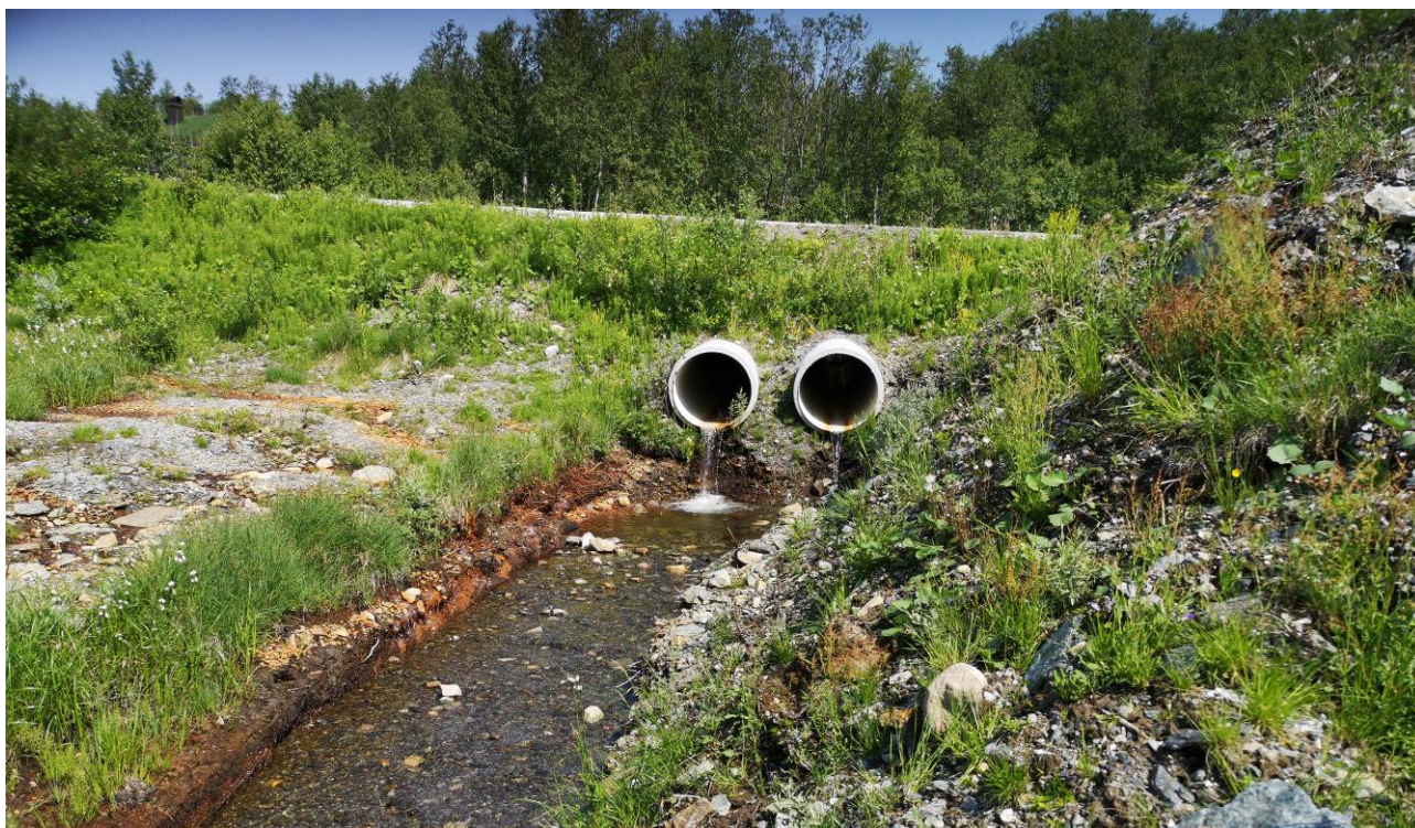
Stikkrenner under Finntøppvegen – bekken langs Bergojordet.
