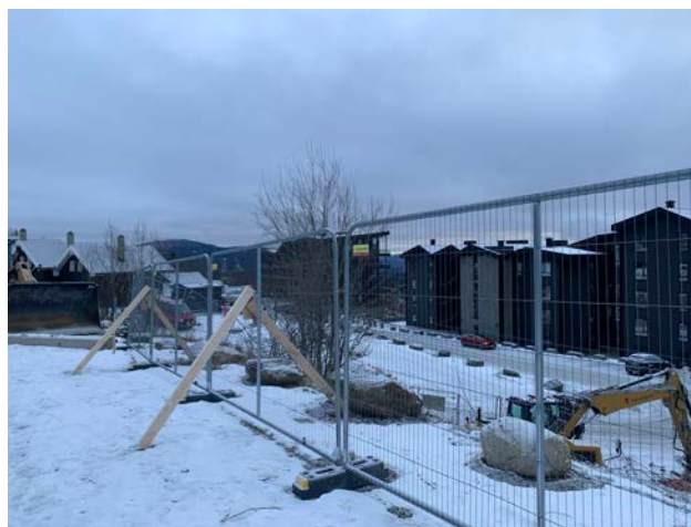
Dagens situasjon er preget av mye byggearbeider
