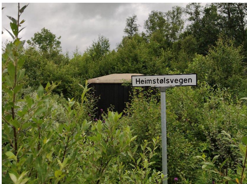
Figur 19: Eksisterende trafo i krysset Øvrevegen x Heimstølsvegen.
