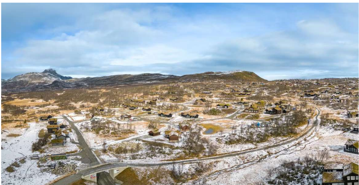
Sørre Garli – Dronebilde – viser aktuelt tomt – her benyttet som rigg- og anleggsområde (Container mm. synlig)
